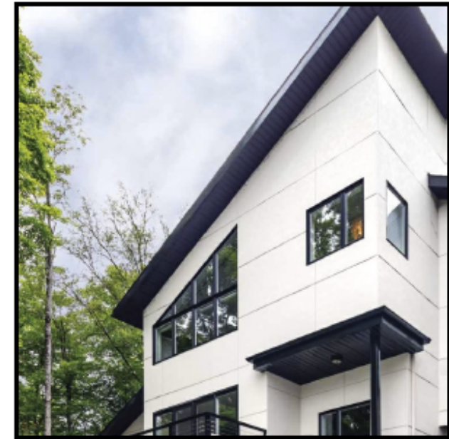
4 PANNEAUX DE FIBROCIMENT BLANC ARTIC - FINI STUC CIE : JAMES HARDI
